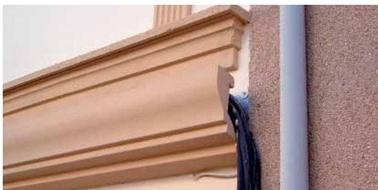
Foto: Solución para ocultar cables en las fachadas.
