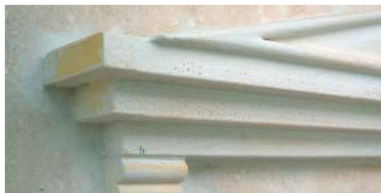
Foto: Soporte fijación por cemento cola.
