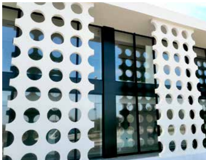
Celosías de las nuevas oficinas del GRUPO BAUZA prefabricadas con el sistema MOLDU3
