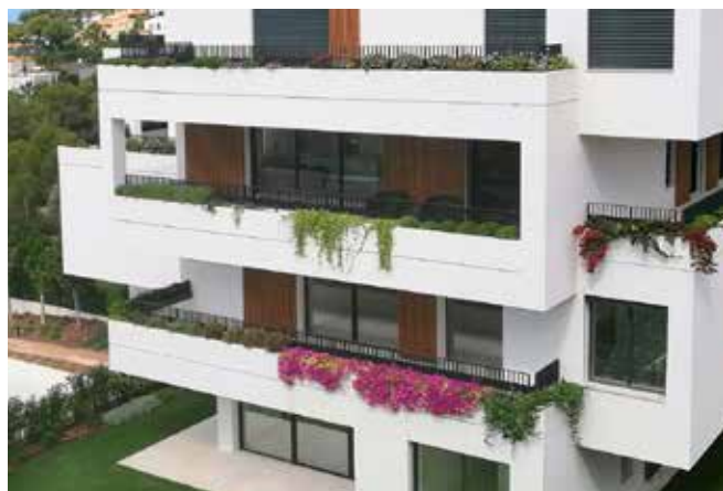
Jardineras acabadas con el mismo mortero SATE de las fachas. Promoción GREEN ELEMENTS.
