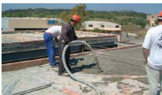
Foto: Obra Edificio de oficinas Viposa. Formación de pendientes y aislamiento térmico.
