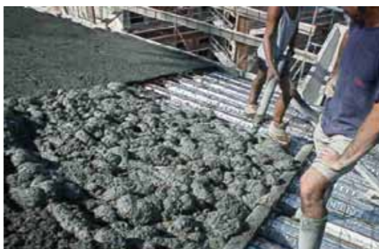
Foto: Obra Hotel Bendinat. Instalación aislamiento térmico.
