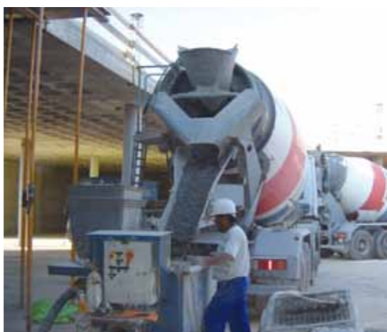
Foto: Para grandes cantidades es posible la utilización de camiones hormigonera.
