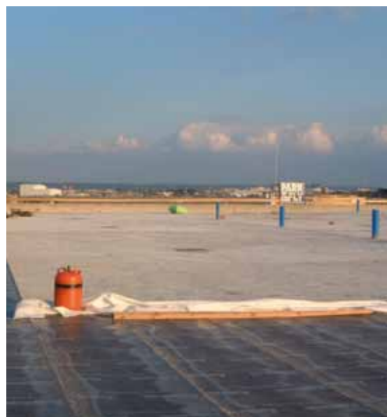
Foto: Obra ampliación Centro Comercial Carrefour. Formación de pendientes y aislamiento térmico de cubierta.
