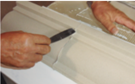
Las juntas entre molduras se salvan con el mismo mortero de recubrimiento.
