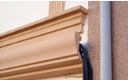
Solución para ocultar cables en las fachadas.
