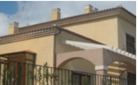
Cornisas MOLDU3 colocadas en un edificio de nueva construcción.
