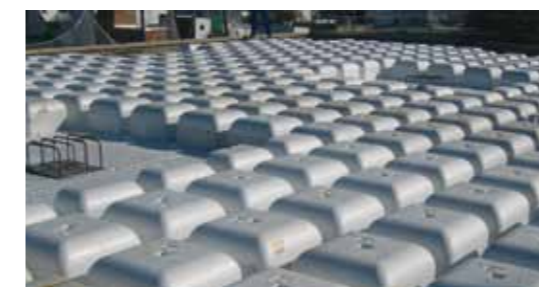
Foto: Exquisita alineación de nervios, obligada por la autoalineación de bases y tapas.
