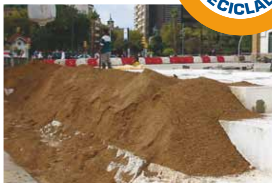
Foto: Obra estación intermodal. Gracias a la realización de las dunas de poliestireno se consigue una reducción de peso.
