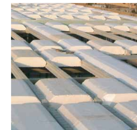
Foto: BOVEDECO consigue reducciones en el forjado de entre 100 a 130 kg/m 2
