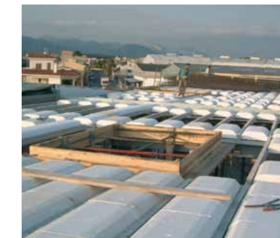
Foto: BOVEDECO ahorra costes en la colocación
