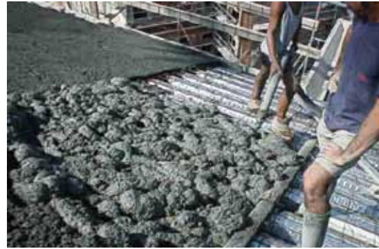
Foto: Obra Hotel Bendinat. Instalación aislamiento térmico.
